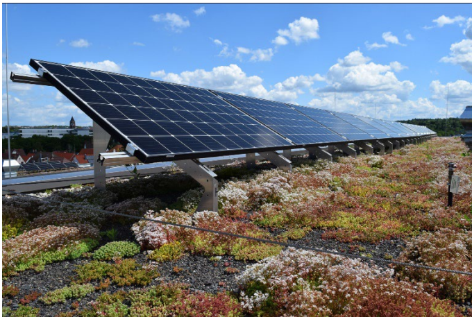
Bild: Gelungene Kombination: Gründach und Photovoltaik. Foto: Bundesverband GebäudeGrün e. V.
